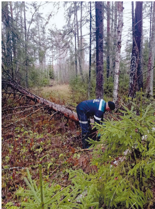
Расчистка лесных просек
